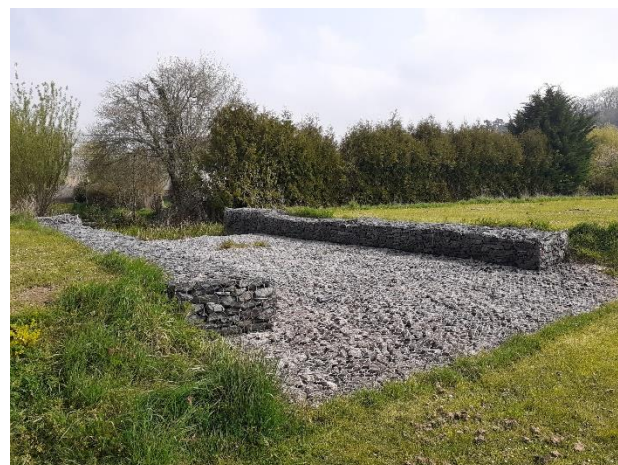
Figure 66 : Déversoir crée sur la digue est de Navarre rabaissé pour réduire le risque de rupture de la digue protégeant une lignée de bâti faisant obstacle à l'écoulement des eaux
